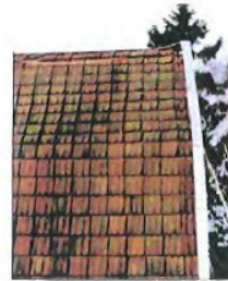
Tegeltak åldras vackert till skillnad från plåt och betong.
