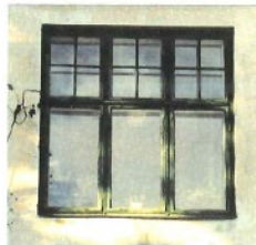
Spröjsat jugendfönster med småspröjsar ovanför tvärposten
