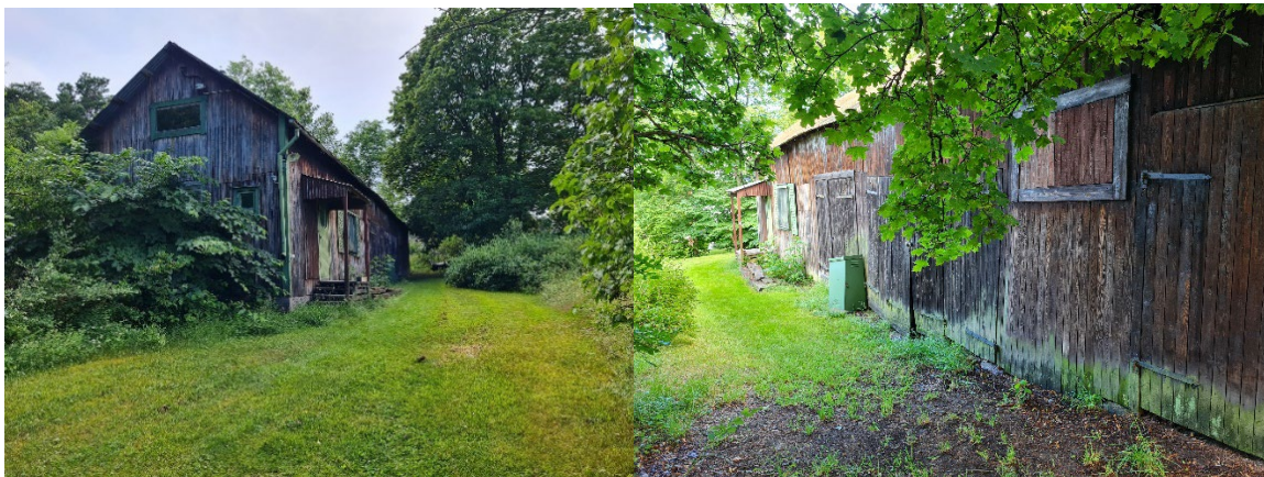
Bilder på ladan/ekonomibyggnaden på den västra delen av fastigheten.
