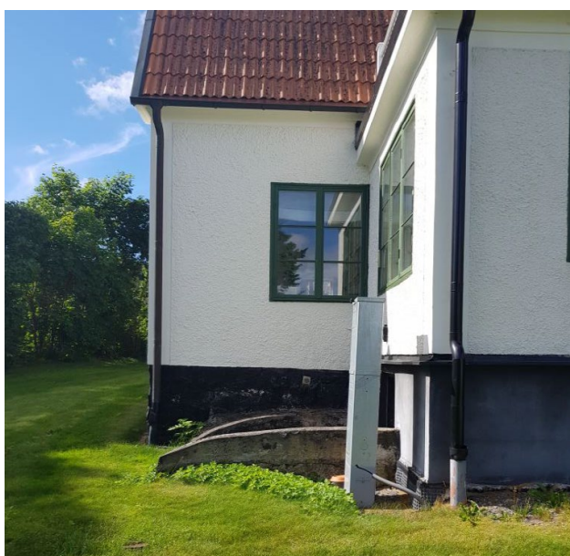
Bilden visar stuprör som leds ned i marken från befintlig byggnad. Källa: Dagvattenutredningen
